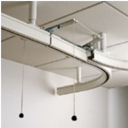
Aiguillage de rail
